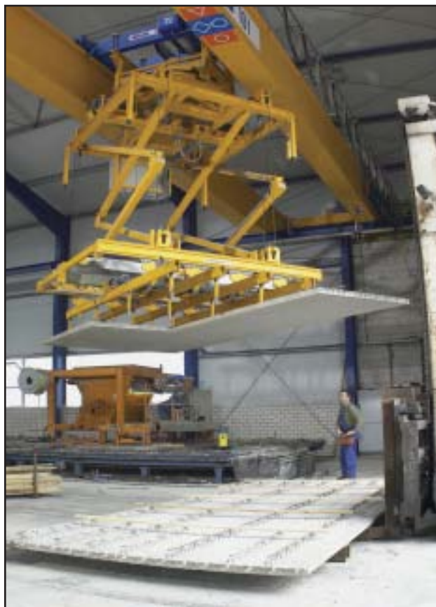
Подъем потолочных плит
