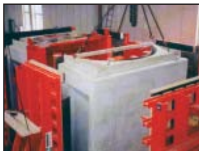
С бетонного элемента снимается опалубка
