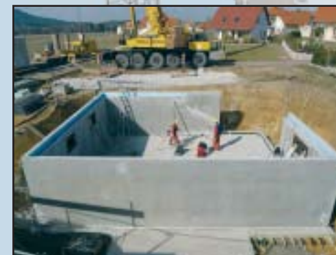
Двойная стена с внутренней изоляцией
