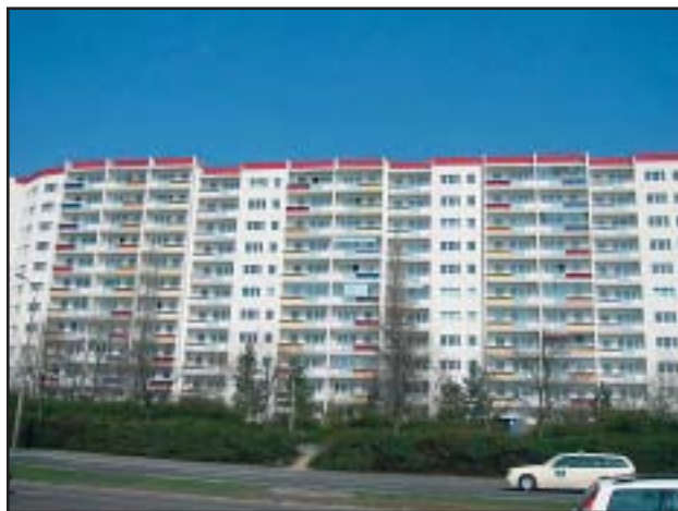
Фасадные элементы конструкции типа «сэндвич»
