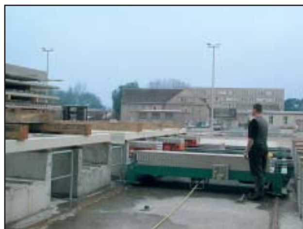
Тележка для вывоза продукции на складской площадке
