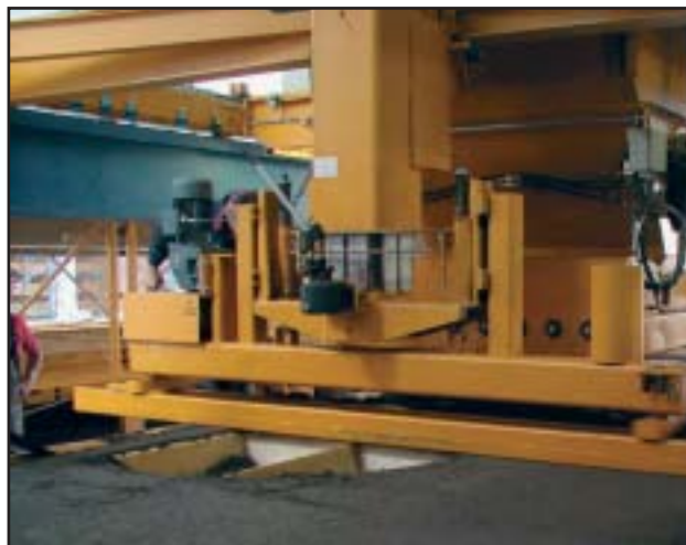
Выравнивающее приспособление на бетонораздатчике
