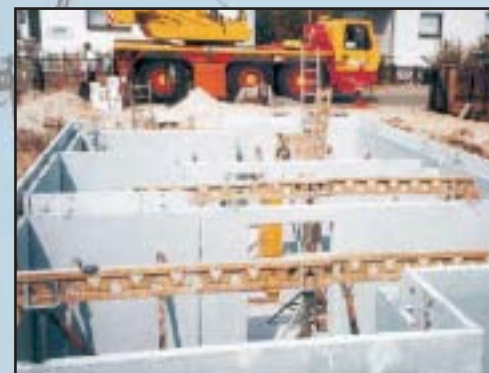
Монтаж двойной стены (подвальный этаж)
