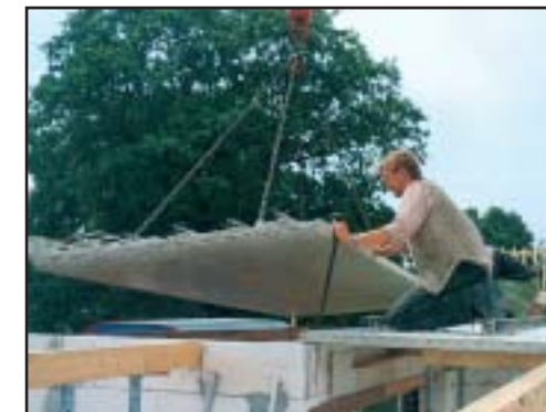
Монтаж элементных перекрытий и двойных стен
