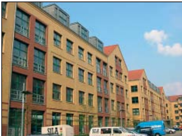
Фасадные элементы конструкции типа «сэндвич», облицованные клинкером
