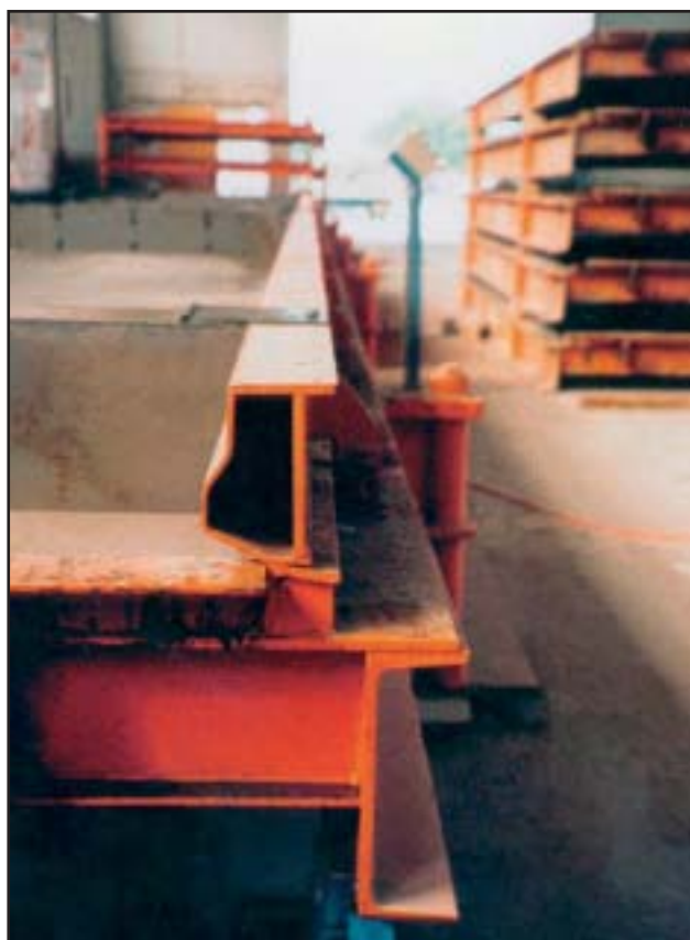
Механически откидывающаяся опалубка
