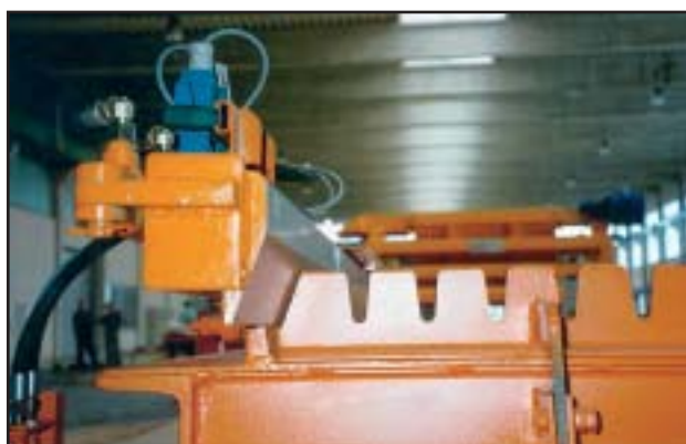
Специальная опалубка, поднимаемая гидравликой
