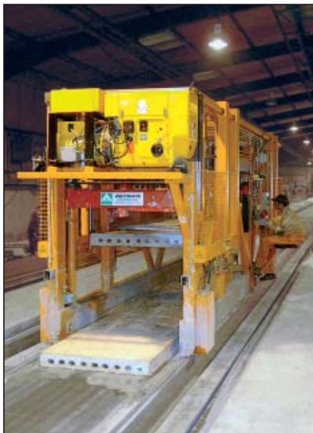
Подъем пустотелых плит перекрытия
