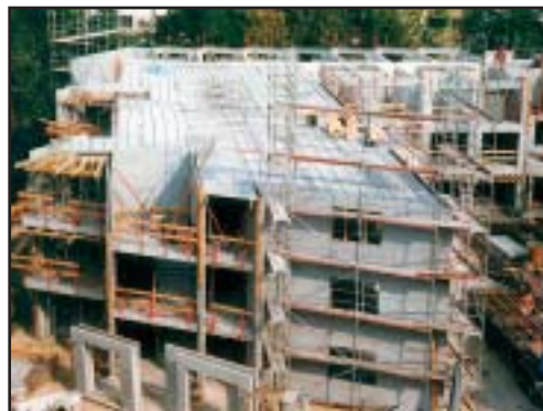
Монтаж элементного перекрытия
