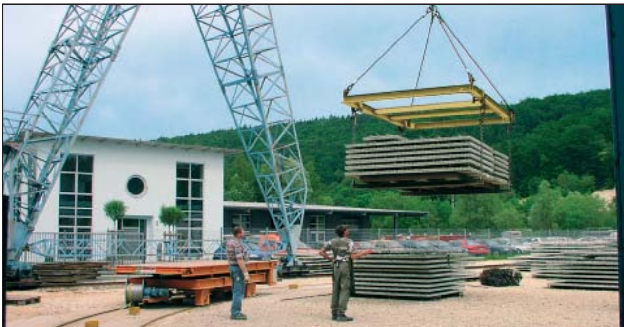
Траверса для штабеля потолочных плит
