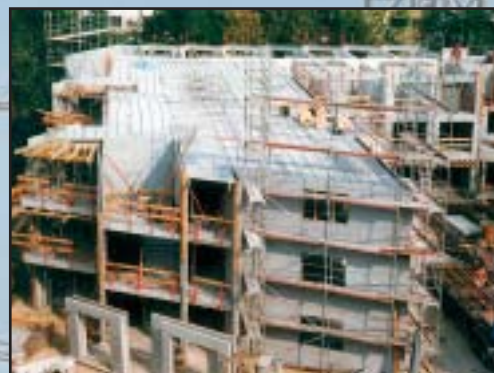
Монтаж двойных стен
