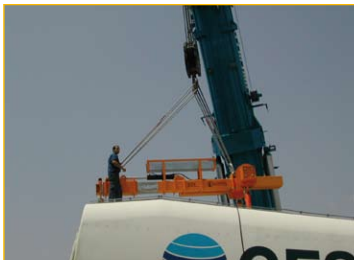
Траверса до 80 тонн с гидравлическим механизмом для монтажа ветро-генератора.
